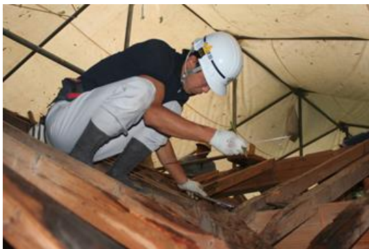
▲牧野滝社改修工事
