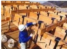
▲桁への巻金、カスガイの取り付け
