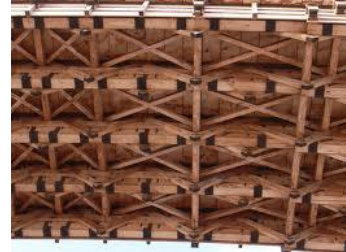
▲5橋全ての架け替えが完了した平成の錦帯橋(2001～2004年)
