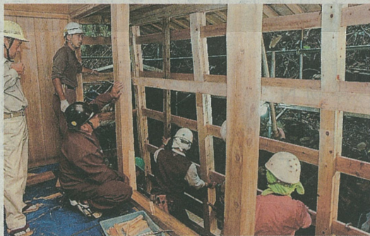
滝社の拝殿の一部を改修する信州職人学校の受講生ら
