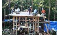
東屋建て方実習
