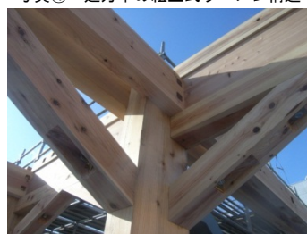
写真⑥ 立体交差する柱・梁・方杖
