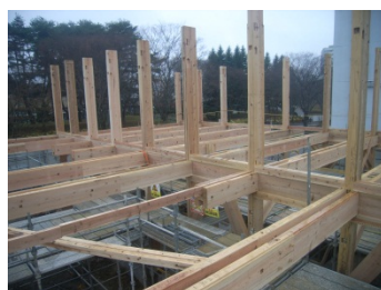
写真④ 建方中の組立式ラーメン構造
