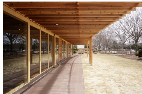
写真③ 耐風ルーバーに支持される開放的なサッシ面
