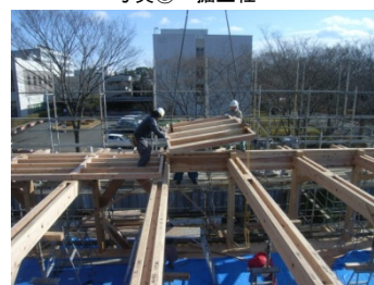
写真⑦ 床版ユニットの建込
