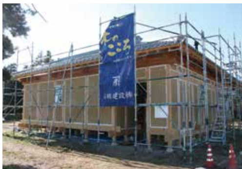
独立早々木工事を丸ごと引き受けた石場建て土壁の住宅
