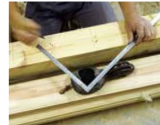
■墨付け作業 曲尺(かねじゃく)を使って木材に印を付ける墨付け作業。
